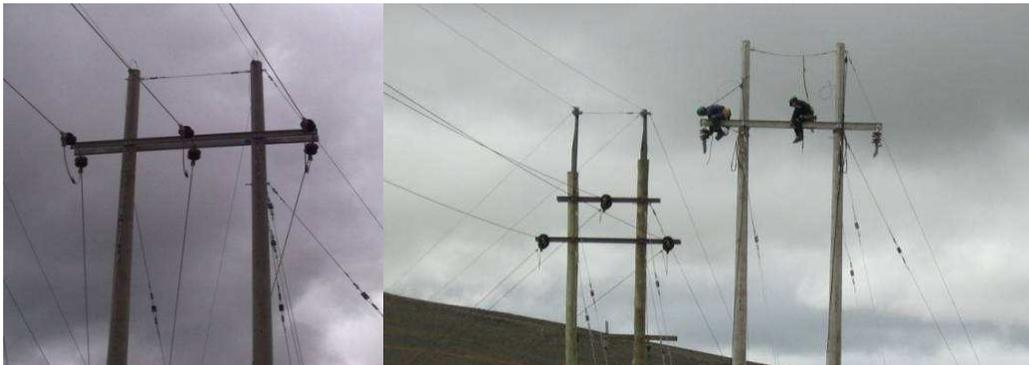
Fig.7 Utilización de conductor de guarda en líneas de media tensión.
